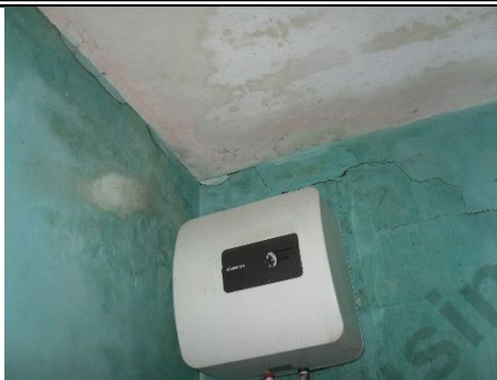
Ông Hiếu phản ánh, nhà ông bị nứt khi xây dựng cây xăng
