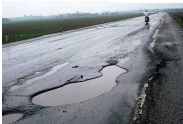
Đoạn đường tránh qua TP Hà Tĩnh hư hỏng nặng.
